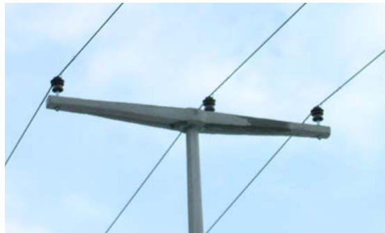
Fig. 8. Top of supporting pillar ( 10 kV , “ KRAVLJI DO - ŠLJIVOVAC “ )
